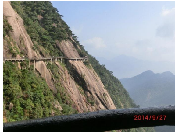
登山索道(支柱方式)と落下防護手すり(手前)
