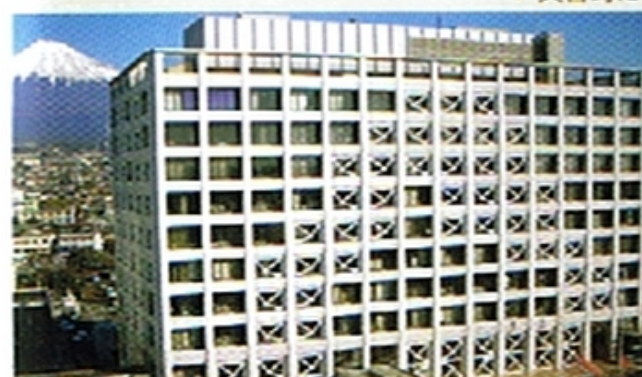
富士市役所 ●SRC造 10階 ●21,000㎡ ●193基
