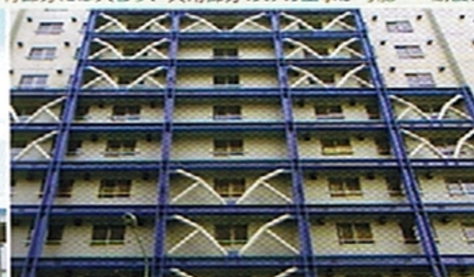
M社社宅 ●SRC造 14階 ●14,583㎡ ●44基
