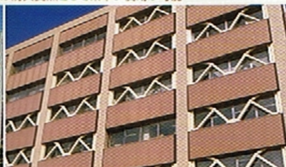
秋田県庁 ●RC造 6階 ●15,724㎡ ●126基
